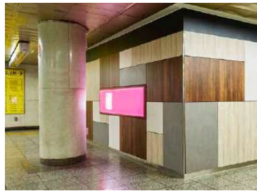
Paredes y Columnas
